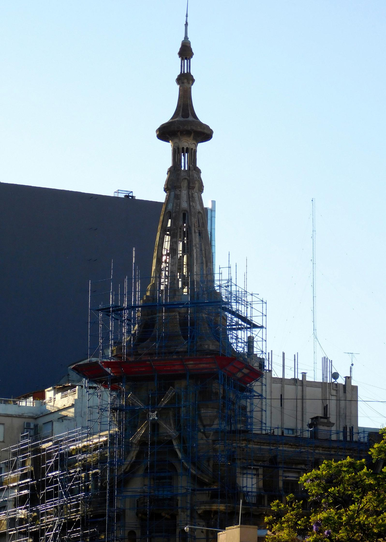
El Gobierno porteño, se ocupó de la puesta en valor de la fachada, cubierta y cúpula. La primera se limpió mediante nebulización, un proceso que logra un lavado profundo sin dañar la estructura, además de la colocación de material similar al original para construir los dibujos de los balcones y la reposición del faltante. A su vez, se mejoró la iluminación exterior.
